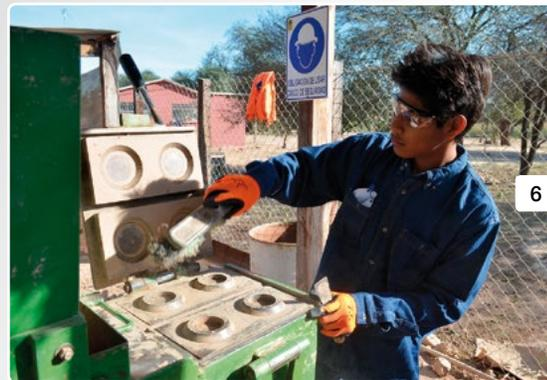
7. Colocado de la mezcla de suelo - cemento en el depósito de la bloquera
